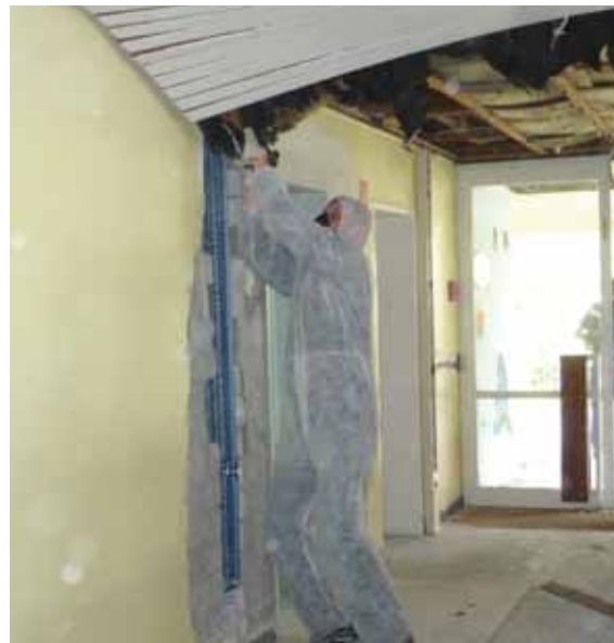
Abbruch und Entsorgung
