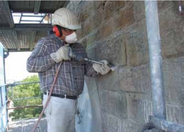
Die Fugen des Kirchturms werden saniert
